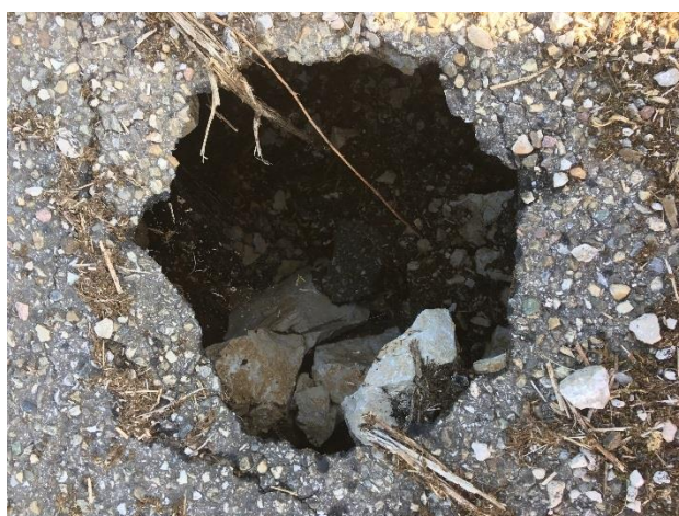
L- Cavité karstique observée sur le chemin au centre de la zone d'étude (09/05/2022)
